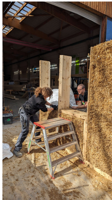
Rückbau Musterwand „Cradle to Cradle“
