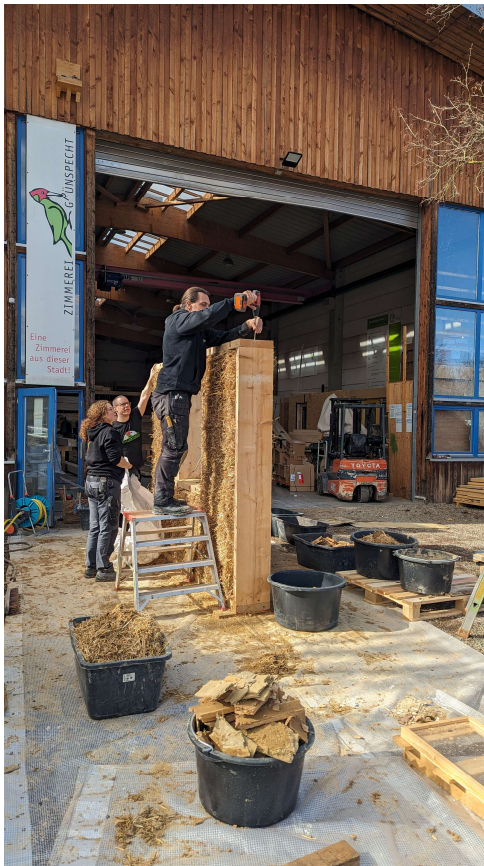
Rückbau Musterwand „Cradle to Cradle“
