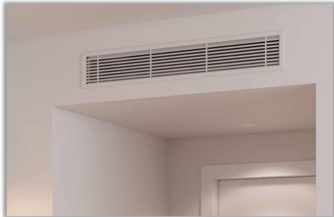
Fan Coil / Kanalgeräte
