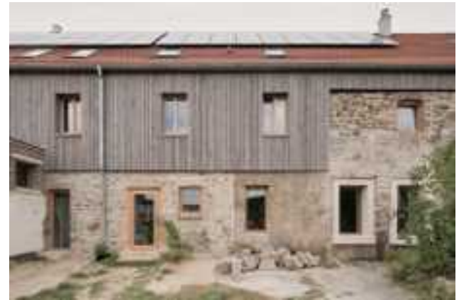
Freigelegte Südseite mit neuen Öffnungen und Lärchenverschalung | während
