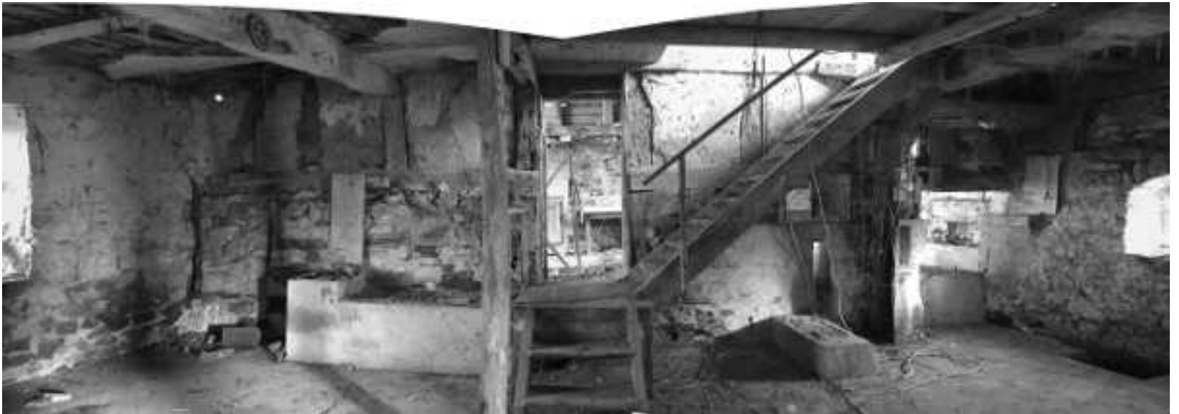
Ehemalige Mühle und Blick in die alte Scheune | vorher
