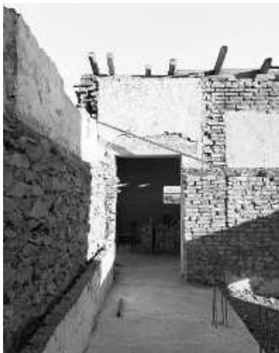
Flur zum Lichthof im ehemaligen Kartoffelkeller und Hühnerstall | während
