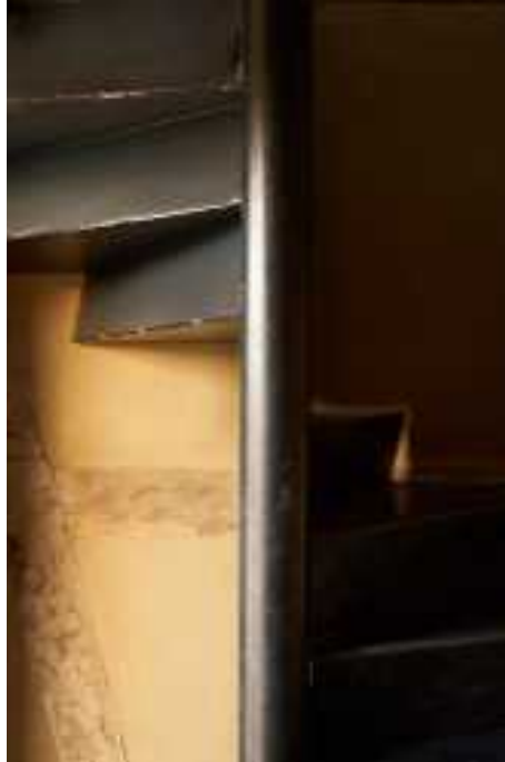
Neue Stahltreppe im Gästebereich
