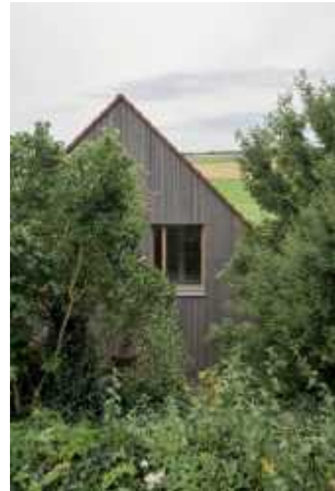
Wohnen in der alten Scheune innen und außen | nachher
