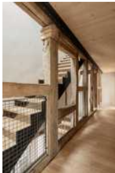
Freigelegte Außenfassade im heutigen Flur | nachher
