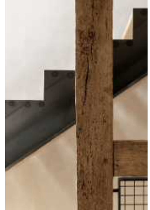
Neue Stahlwangentreppe im alten Stall und Heuboden
