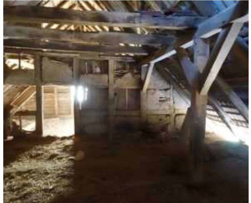
Altes Sparrendach mit Kehlbalkendachstuhl | vorher
